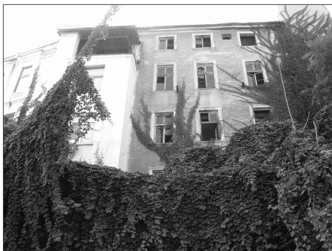
Източната фасада на тютюневата фабрика
